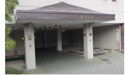
① フロント前駐車場 12台
