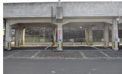
⑤ 高架下駐車場 6台
